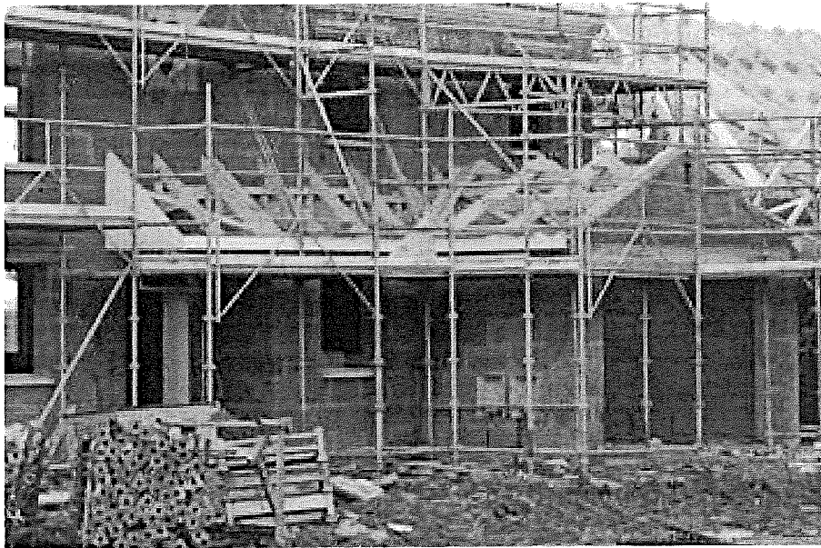
Figure 3. Échafaudage de pied
